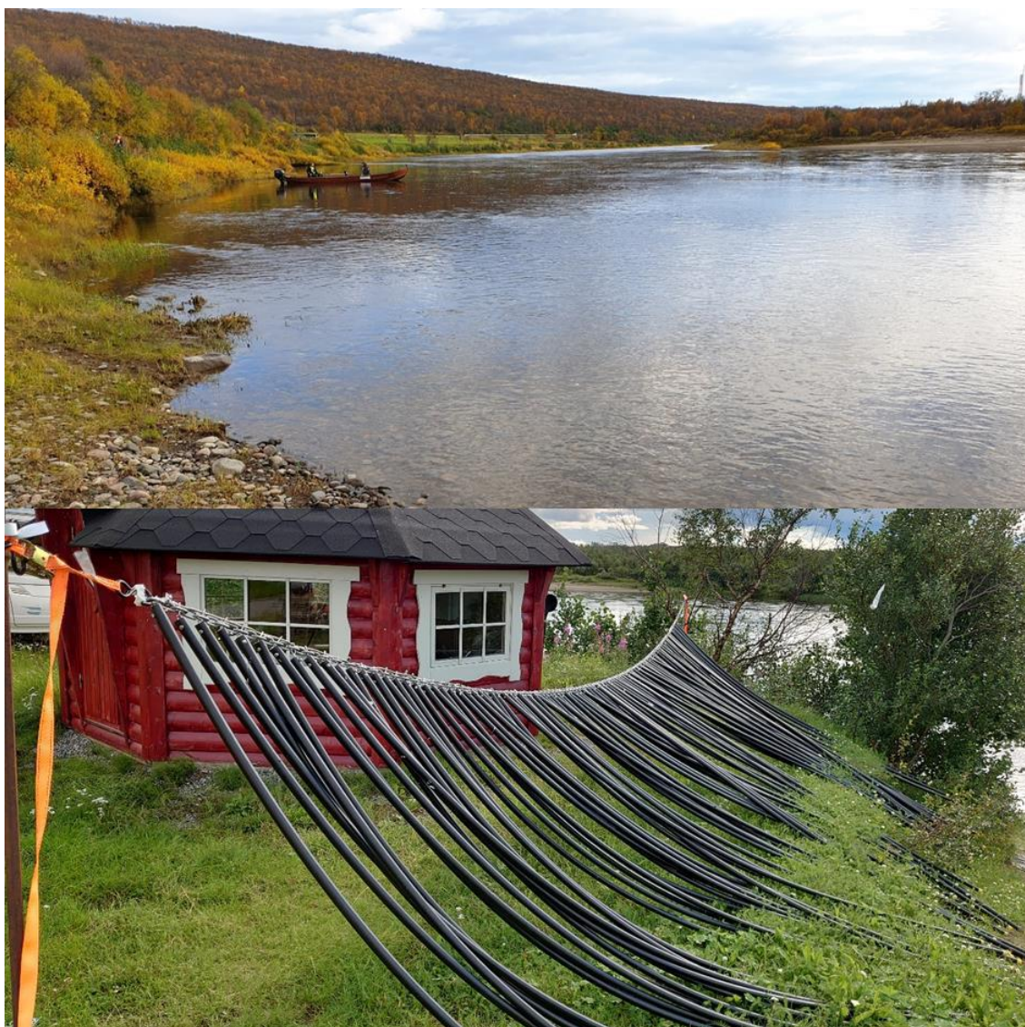
Bildeserie 2. I området ved Seidaholmen (øverste bilde) nedstrøms Tana bru prøver Tanavassdragets fiskeforvaltning ut et ledegjerde bygd av sammenkoblede plastrør (nederste bilde). Øverste foto: Gunnbjørn Bremset, NINA. Nederste foto: Sigurd Domaas, NINA.
